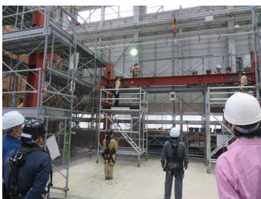
指導に基づき、グループごとに安全に梁を柱に固定する作業が出来ました。このような重量鉄骨の建て方実習を行う建築系の大学は、当大学校だけです。
